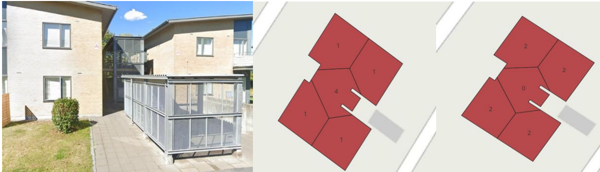
Figur 1: Boligbyggeri med trappeopgang mellem boliger. Figur 2: Boligfordeling inden ændringer. Figur 3: Boligfordeling efter ændringer.
