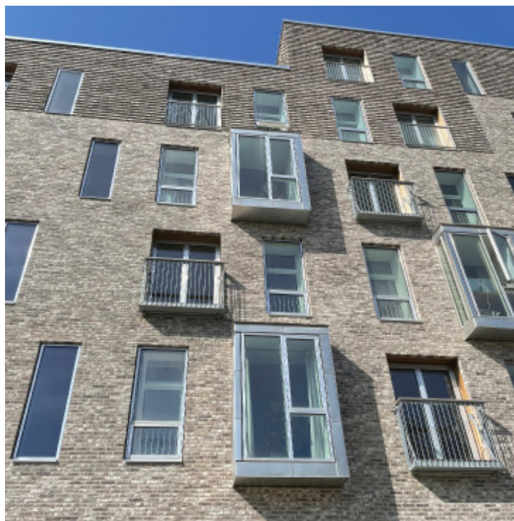
Forskellige typer af vinduesnicher, vinduer og teglsten.
