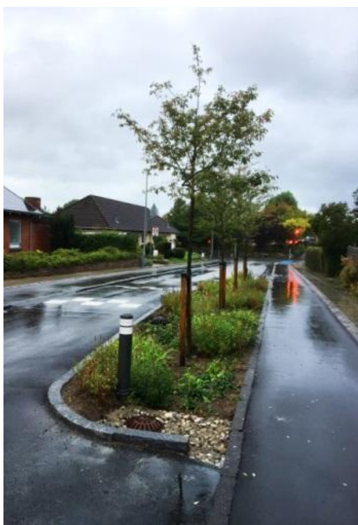
Figur 4-6 Eksempel på vejbed for lokal regnvandshåndtering
