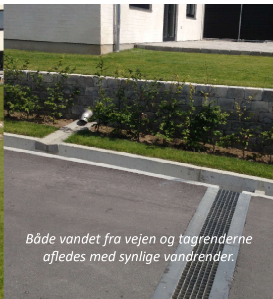
LAR-løsning (lokal afledning af regnvand) ved Kirkebjerggårdsvej i form af vandrender som løber ned i et regnvandsbassin.
