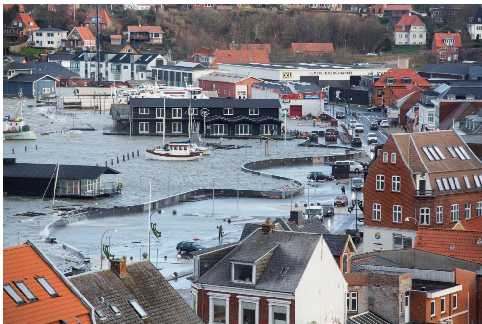
Figur 3-1 Stormflodssikring i Lemvig.
