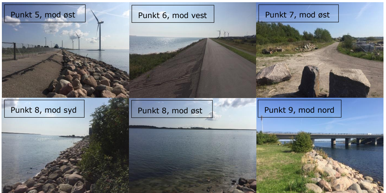
Figur 6-2 Forslag til fortsat sikring omkring Avedøre Holme. Punkterne 5 – 9 illustrerer forholdene omkring Avedøre. Billeder fra punkter 1 – 4 er vist på Figur 5-9 og Figur 5-10.
