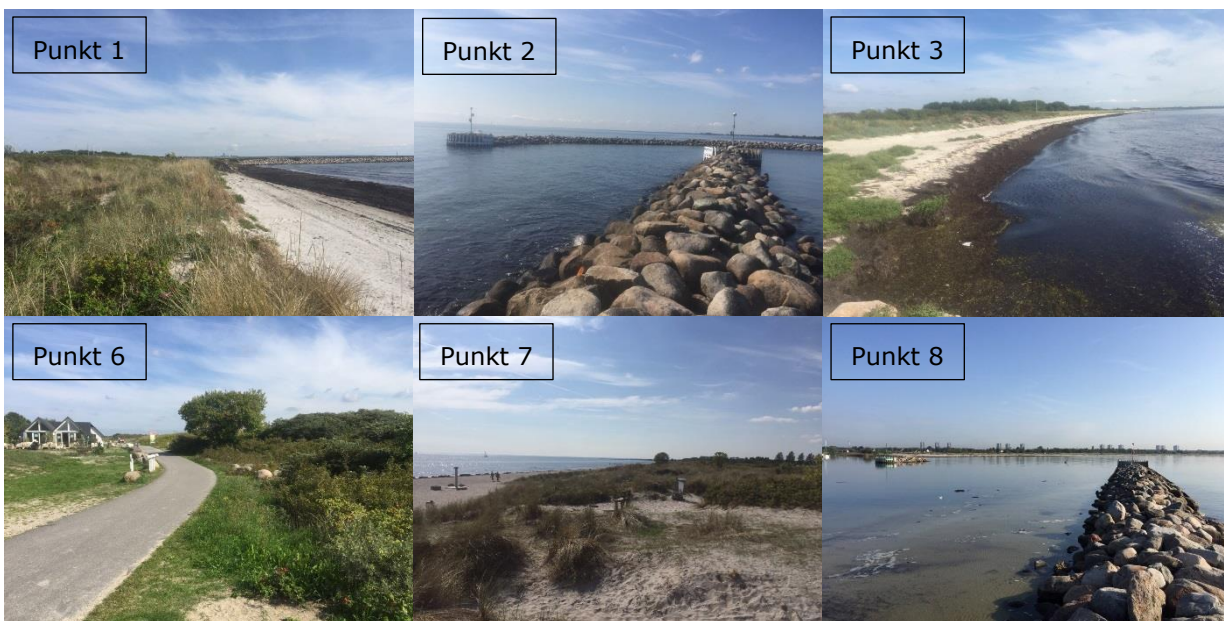
Figur 5-4 Fotos langs forslag til ydre sikring i Ishøj Kommune, for strækningen langs punkterne 3 – 7 er eksisterende klitter, foto for punkt 3, 6 og 7 viser billeder af hhv. klitterne fra stranden mod nord, bag klitterne mod nord og fra toppen af klitterne mod syd.
