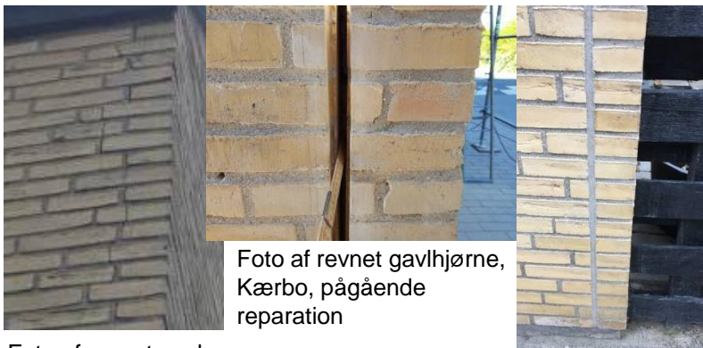
Foto af revnet gavlhjørne på Kærbo, før
