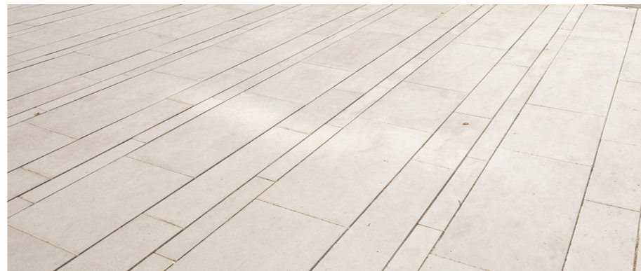
Belægninger med gennemgående fuge understreger retning.
