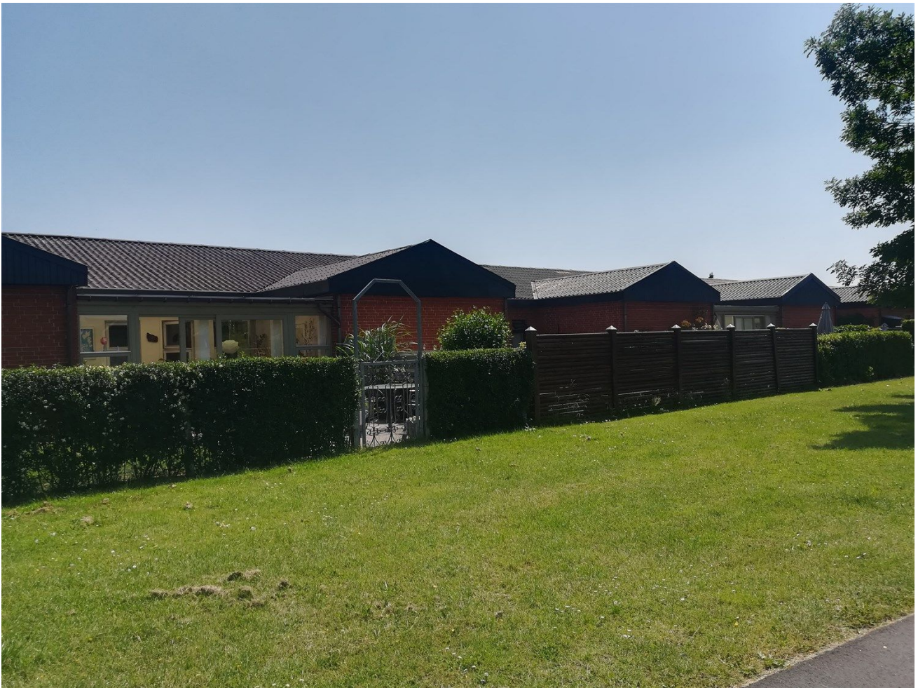
Rækkehusenes facader mod have set fra Lundestien
