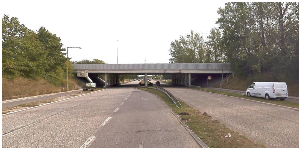
Figur 2 Overføringen af Motorring 4 over Ballerup Boulevard. DDG © COWI.
