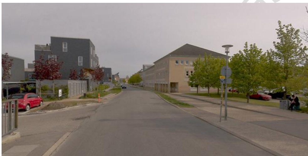
Figur 10 Høje Taastrup Boulevard set mod nord ved broen over Skåne Boulevard. DDG © COWI.
