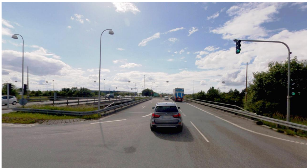
Figur 6 Ishøj Stationsvej set mod vest ved det østlige rampekryds på Motorring 4. DDG © COWI.
