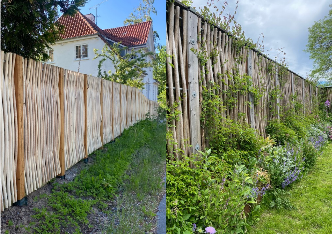
Støjværn med og uden beplantning.
