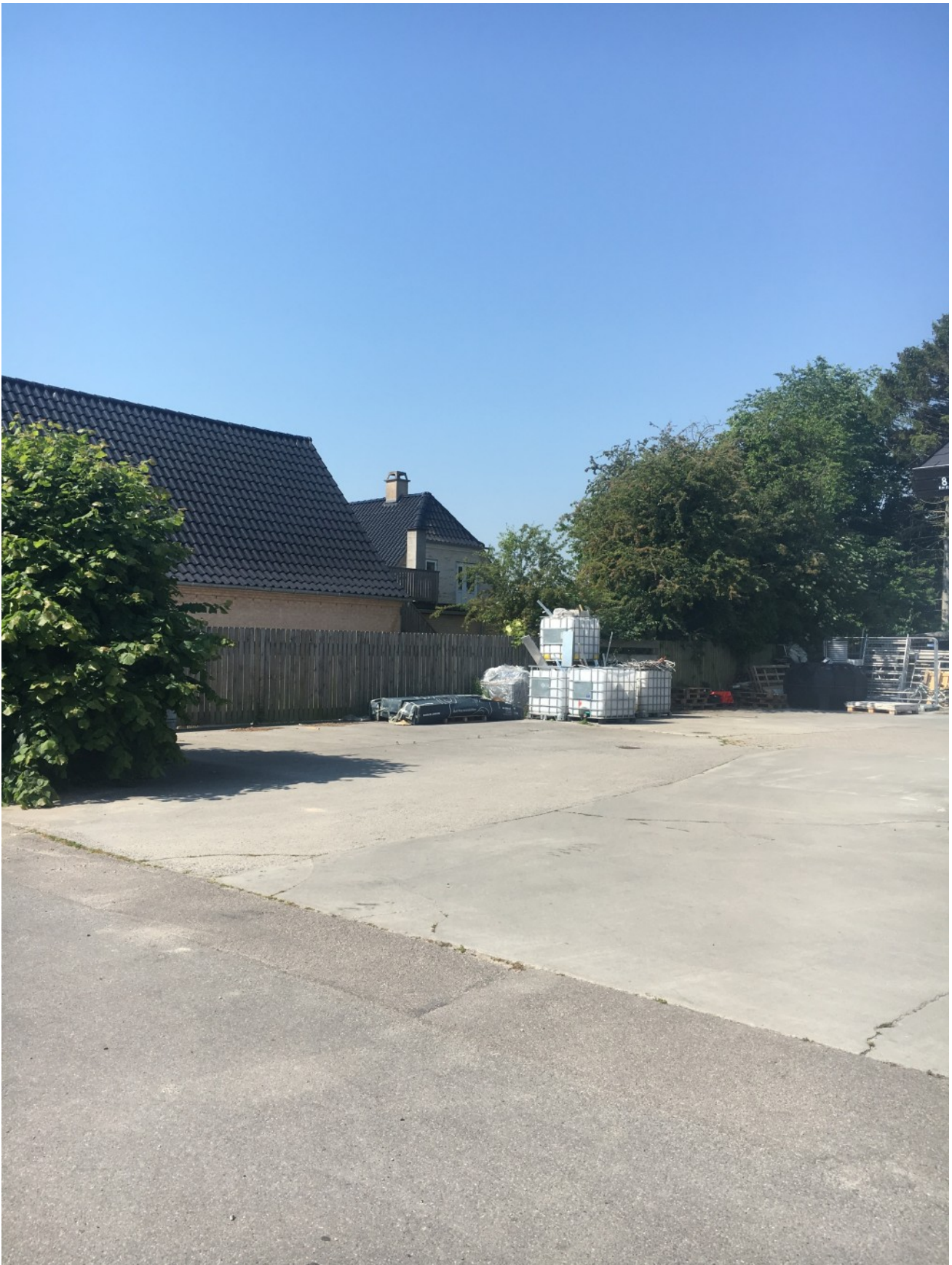
Skellet mellem Pilemøllevej 6-8 og 10, hvor der står et fast hegn i træ samt levende hegn. På billedet ses også den faste belægning som betondæk på Pilemøllevej 6-8.
