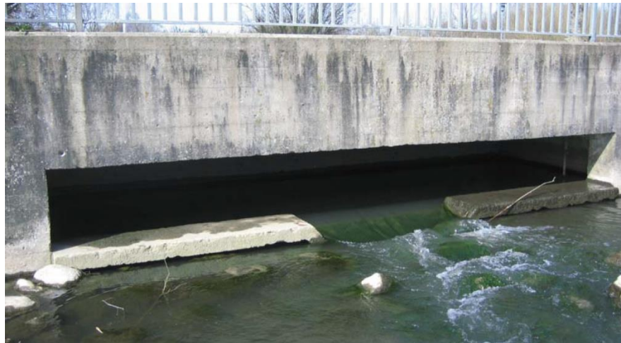
Figur 3.8: Udløbsbygværket i den østlige ende af Ishøj Sø. Foto: NIRAS.
