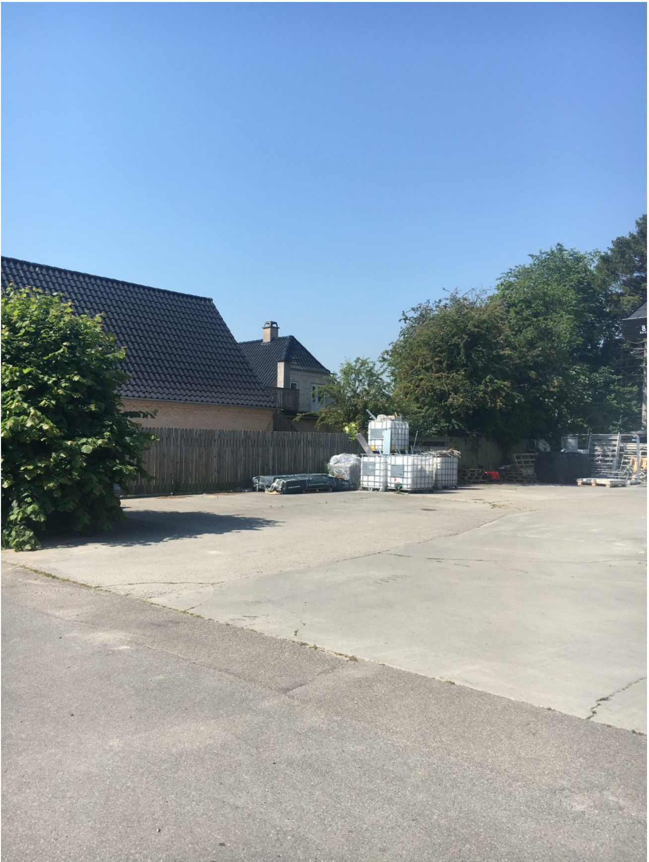
Skellet mellem Pilemøllevvej 6-8 og 10, hvor der står et fast hegn i træ samt levende hegn. På billedet ses også den faste belægning som betondæk på Pilemøllevvej 6-8.
