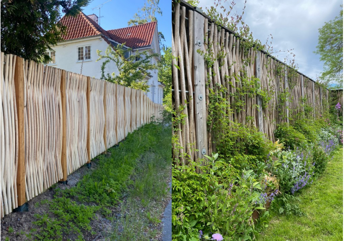
Støjværn med og uden beplantning.
