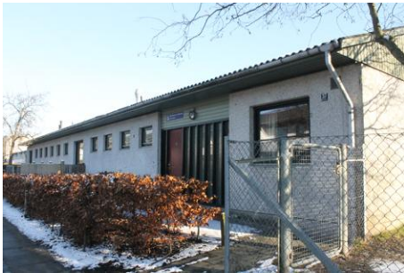
Den eksisterende institution 'Musvitten' der skal nedrives
