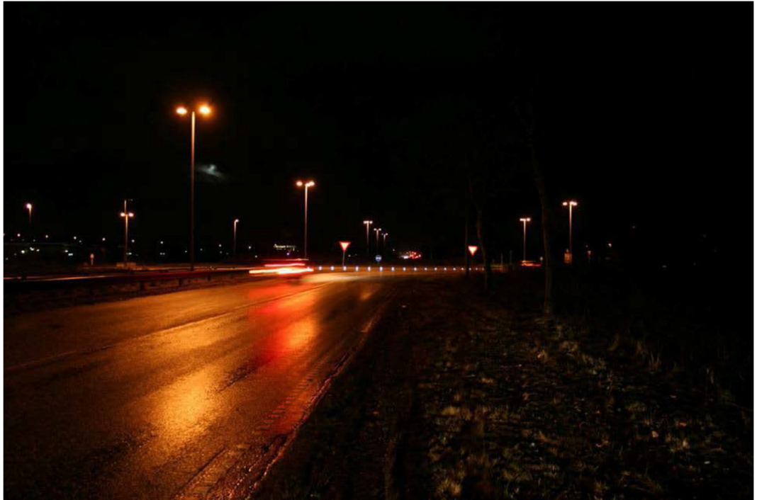
Figur 6. Eksempel på belyst rundkørsel i mørke. Problemet er, at belysningsmasterne på den anden side af rundkørslen kan ses, hvilket nedsætter erkendelsen af rundkørslen og kan føre til ulykker. Denne optiske ledning af trafikanterne skal undgås ved at midterøen beplantes og belyses, så rundkørslen erkendes i god tid. Billedet er taget fra vejregelhåndbogen "Trafiksikkerhedsprincipper" (Vejdirektoratet, 2017).
