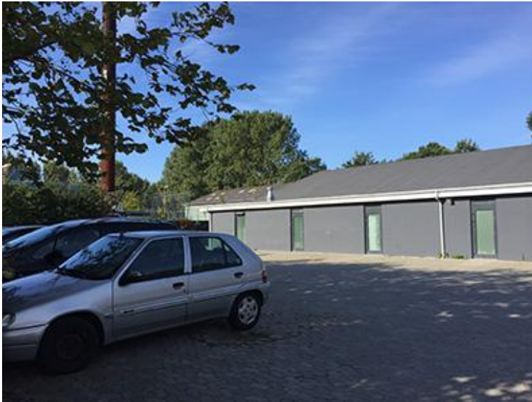
Eksisterende bygning og parkeringsareal
