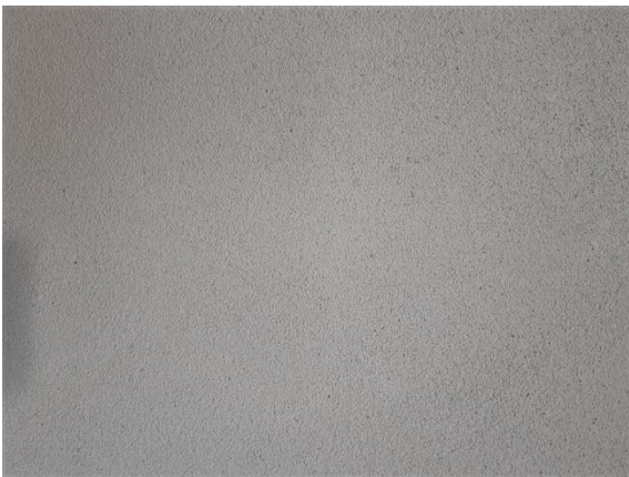
Eksempel på pudset overflade. I dette tilfælde uden på efterisolering og ikke med på murværk.
