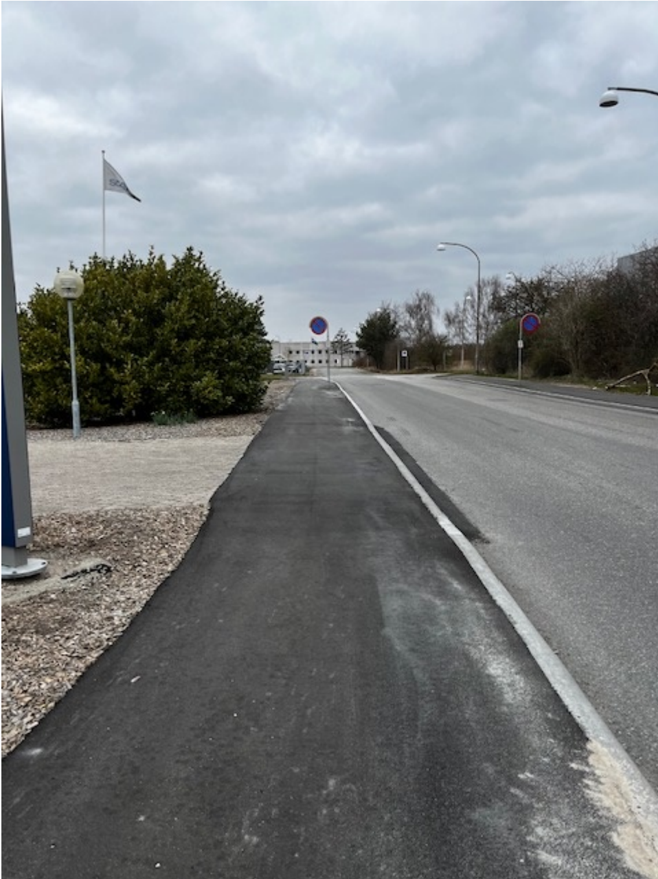
Billede 8: Billedet viser det færdige resultat efter første etape af renoveringen i 2024.
