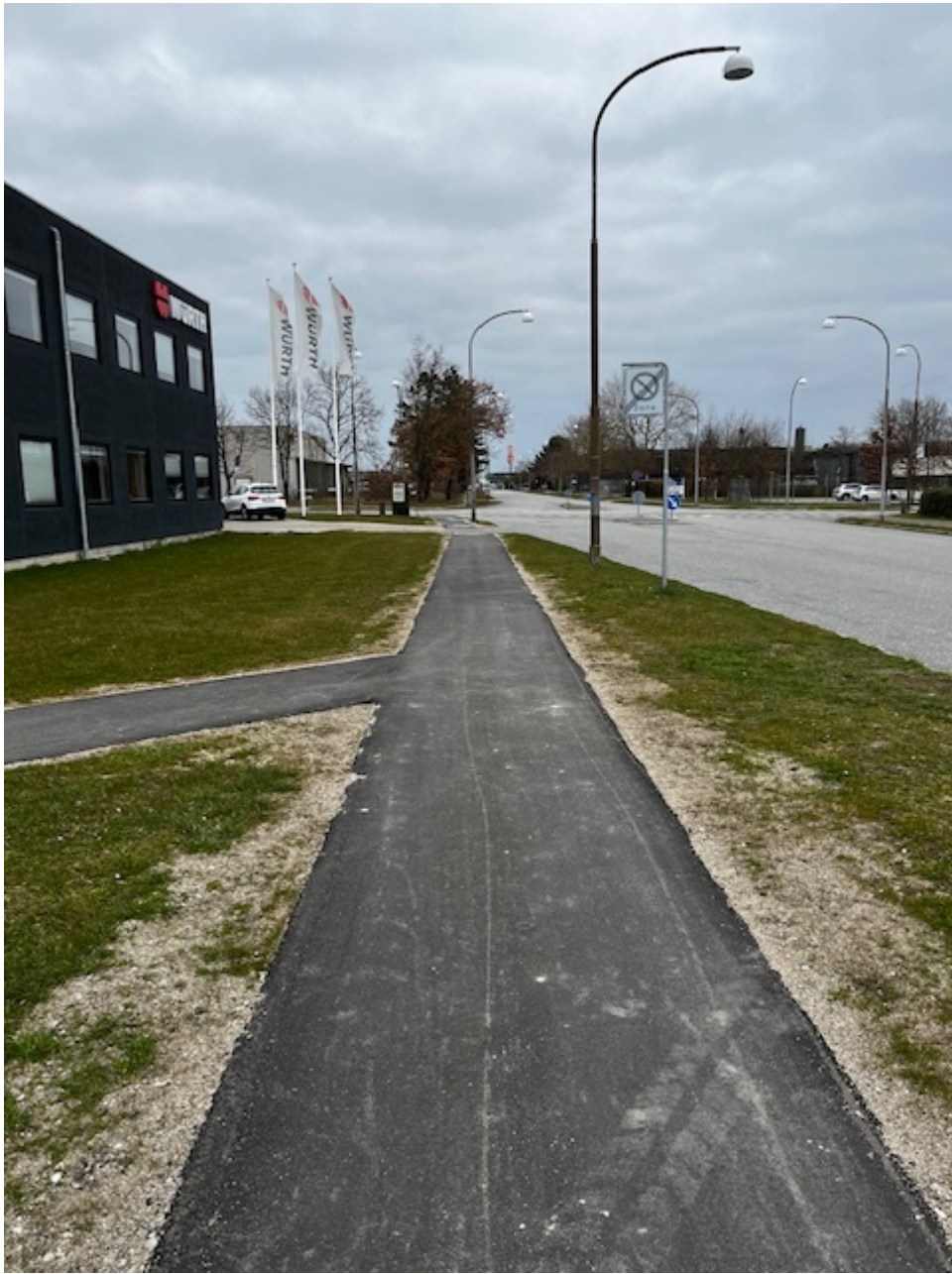
Billede 5: Billedet viser det færdige resultat efter første etape af renoveringen i 2024.
