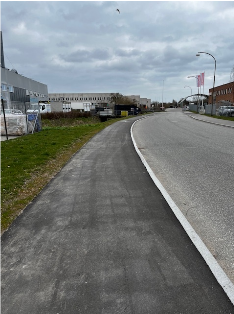
Billede 7: Billedet viser det færdige resultat efter første etape af renoveringen i 2024.
