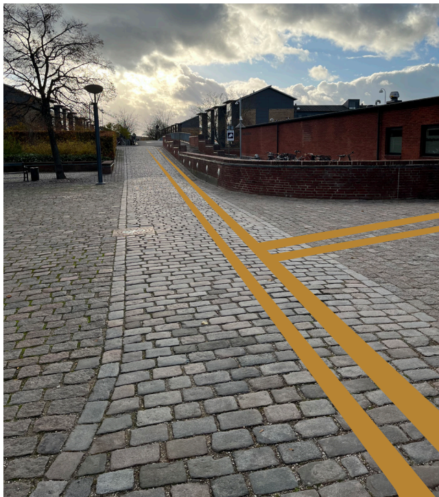
Etablering af to rækker bordursten med stokhuggede brosten imellem.
