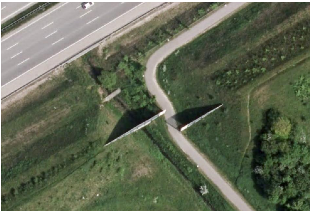
Figur 10: Eksempel på alternativ til tunnelering af vandløb og sti. Fra Olsbækkens underføring ved Køge Bugt Motorvejen i Greve Kommune.
