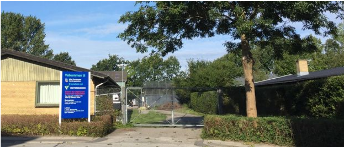
Indgang til Genbrugsstationen og Varmeværkets administrationsbygning. Varmeværkets skorsten rager op i baggrunden.
