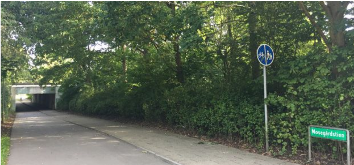
Et kig ned mod tennellen under Ishøj Stationsvej.
