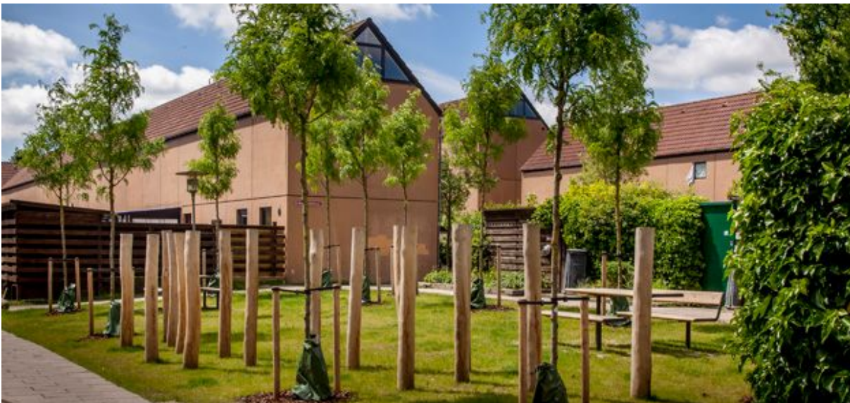
Kig til et af Gadekærets grønne arealer, hvor man kan se bebyggelsens lukkede facade og baghaver.
