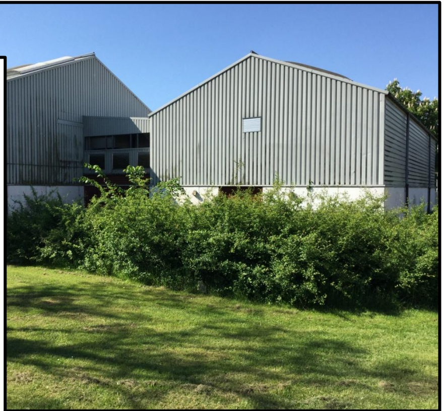
Foto af bygning O. på Strandgårdsskolen
