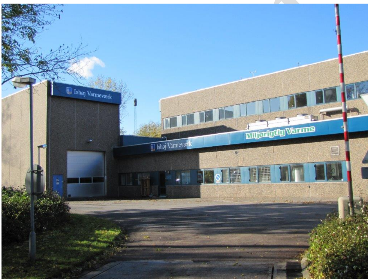
Foto : Indkørsel til Ishøj Vanneværk
