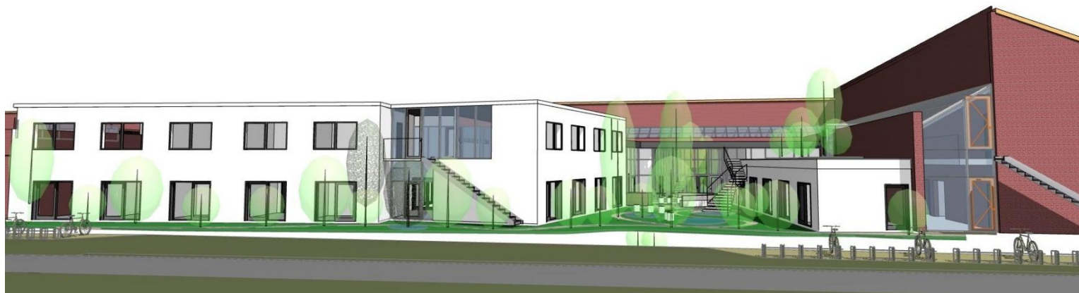
Det nye Sundhedshus ændrer facade mod s-banen.
