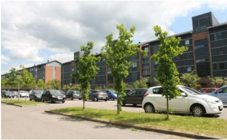
Boligbebyggelsen Vejleåparken og parkeringsareal set fra Ishøj Boulevard
