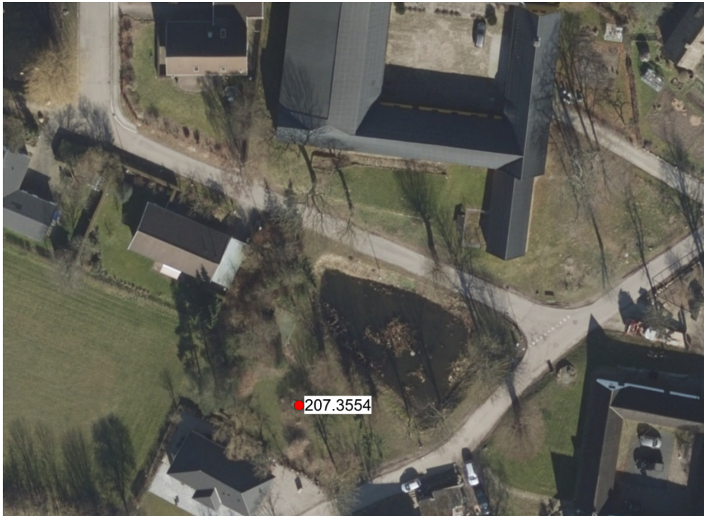
Figur 6-3 Høje Thorstrup vandværk med den aktive boring.
