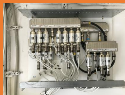
Ovenstående figur viser en abonnentstander efter opgraderingen
