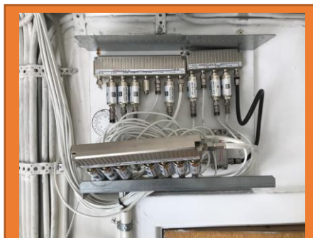
Ovenstående figur viser en abonnentstander før opgraderingen.
