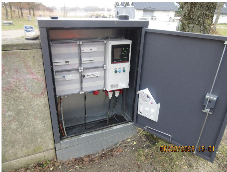
Figur 8 Ny styring i nyt elskab
