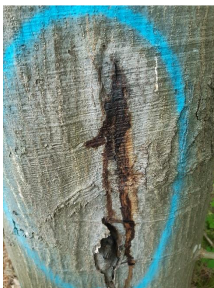
Foto af udsivning, træ nr. 7
