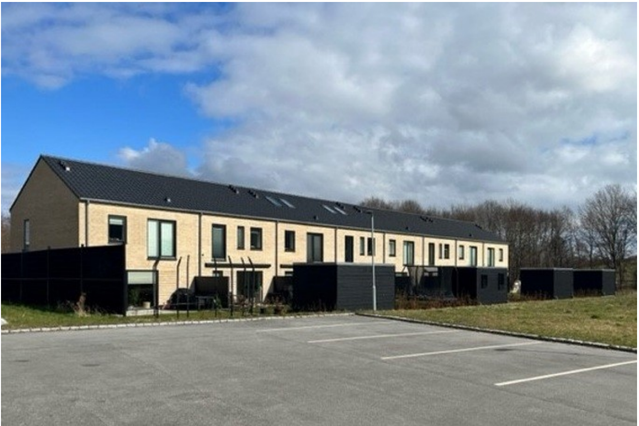
Rækkehusenes sydvendte haver med terrasser.
