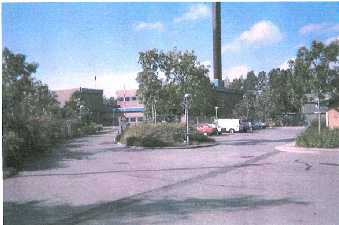
Foto : Indkørsel til Ishøj Varmeværk
