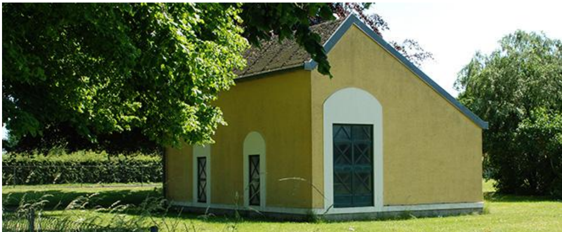
Eksisterende pumpestation ved Allévej.
