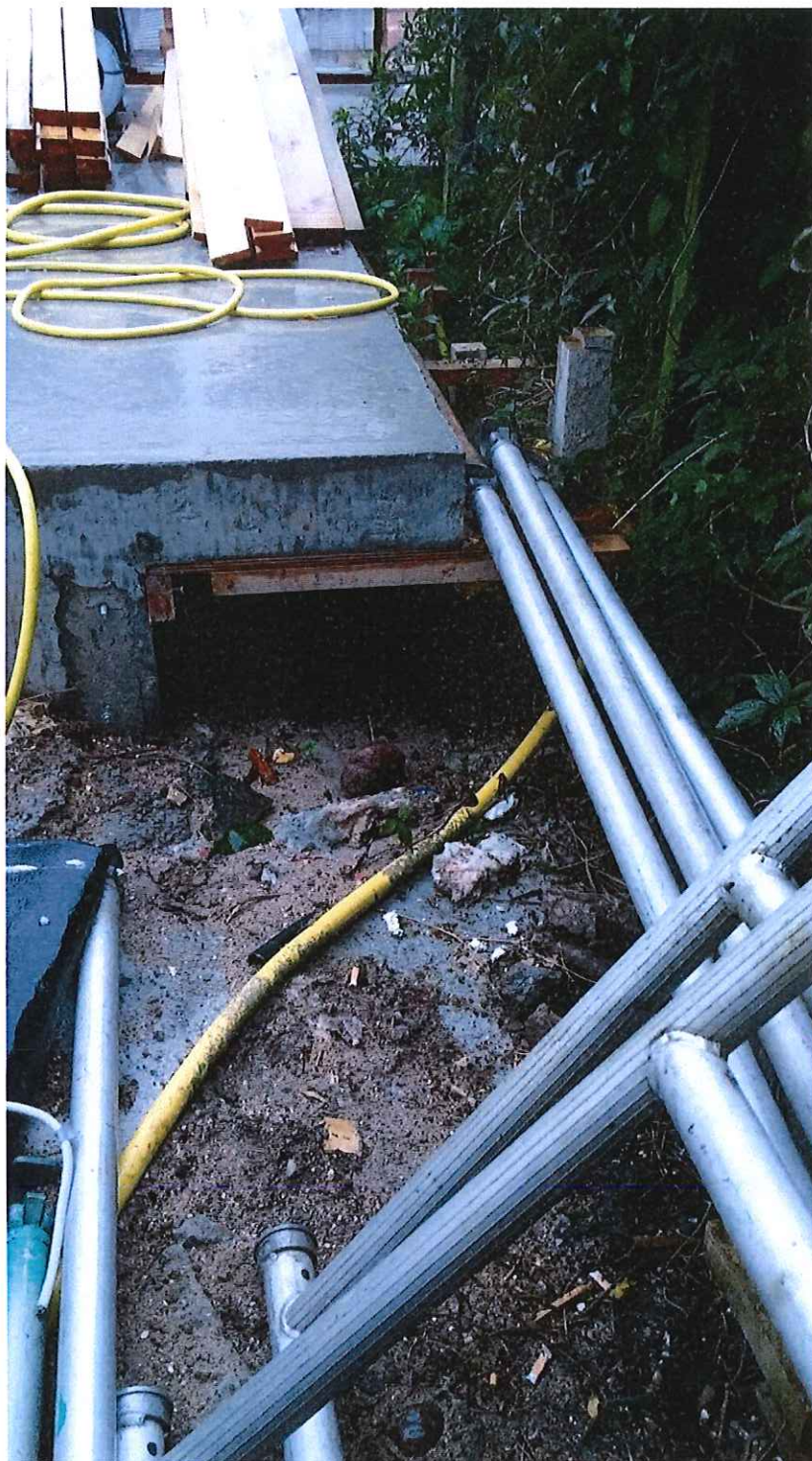
Billede 1 Her ses hvordan terrassen efterfølgende er forøget ud over det støbte fundament
