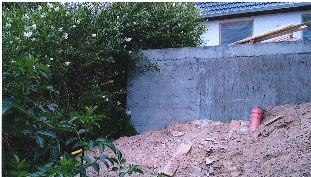
Billede 2 Her ses terrænregulering mod skel der er minimum en meter.
