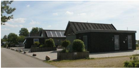
Funktionsbygninger med køkken, bad og toiletfaciliteter
