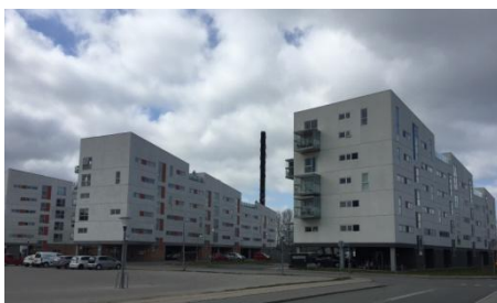
Fasanparken, Lejerbo (venstre) og Baldershus, KAB (højre), Begge tegnet af NB4 Arkitekter
