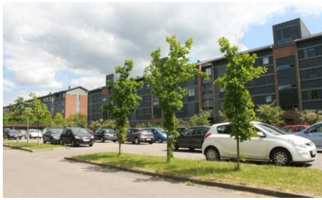
Boligbebyggelsen Vejleåparken og parkeringsareal set fra Ishøj Boulevard
