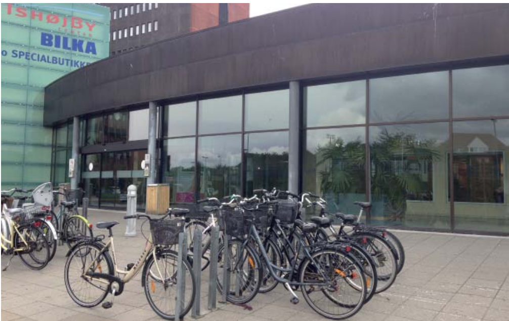
Vinduesparti på buen som er den cirkelformede indgang, som vender ud mod Ishøj Stationsvej.
