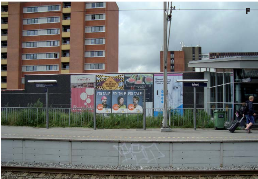
Muren som vender ud mod Ishøj Station.
