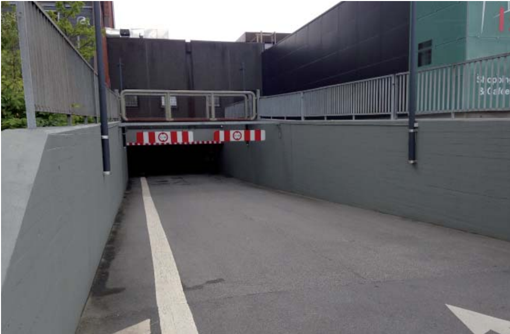
Nedkørsel til parkeringskælder.
