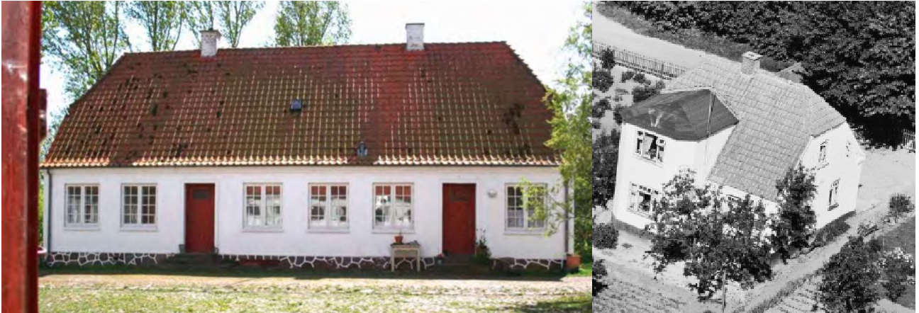
2 eksempler på halvvalme, det ene fra "God byggeskik" og andet et gammelt luffoto fra Torslunde
