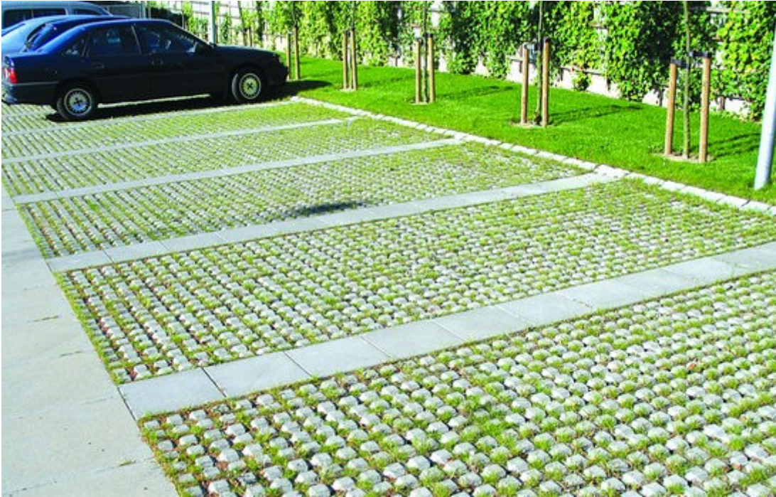
Eksempel på parkeringsplads med græsarmering
