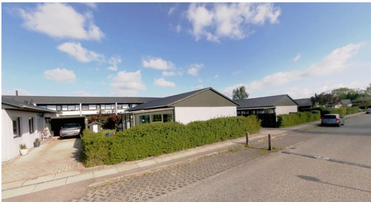
Figur 6: Fritliggende gårdhavehuse i delområde C her set fra indgangssiden mod vejen.
