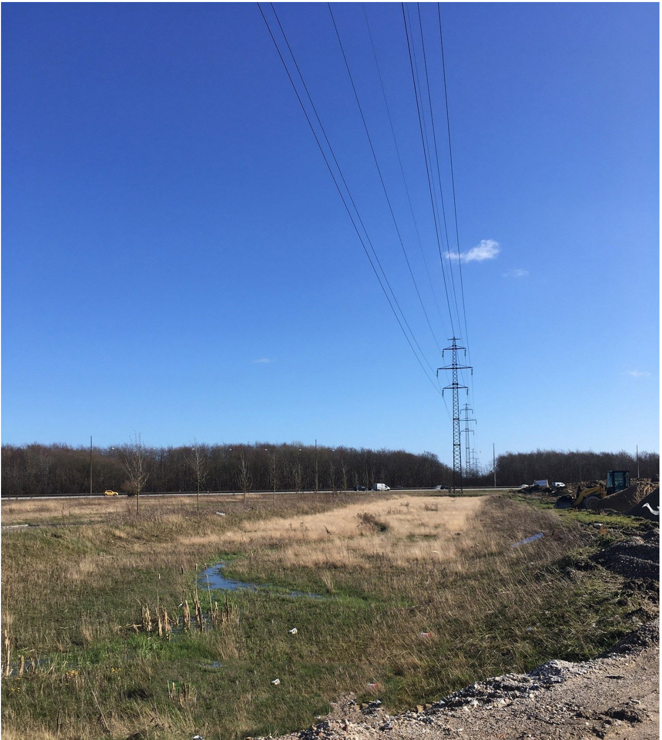
Regnvandsbassin til opsamling af overfladevand.
