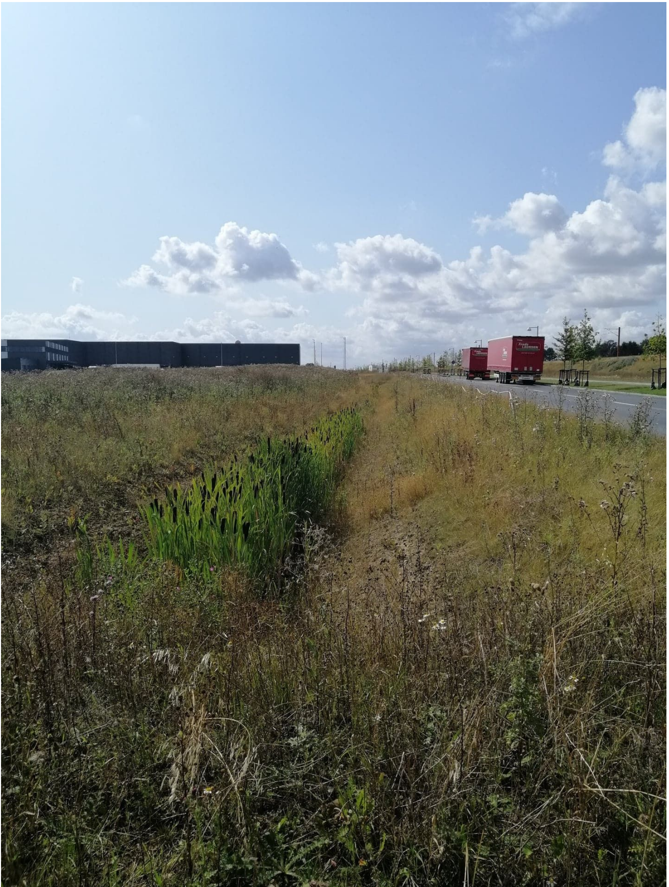
Grøft langs Vejleåvej til opsamling af regnvand.
