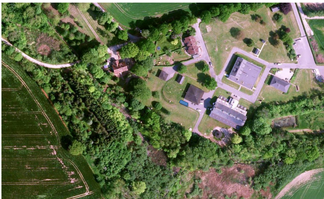
Figur 2: Placering af pilotanlægget (blå markering – ikke målfast) på Værket ved Thorsbro.
