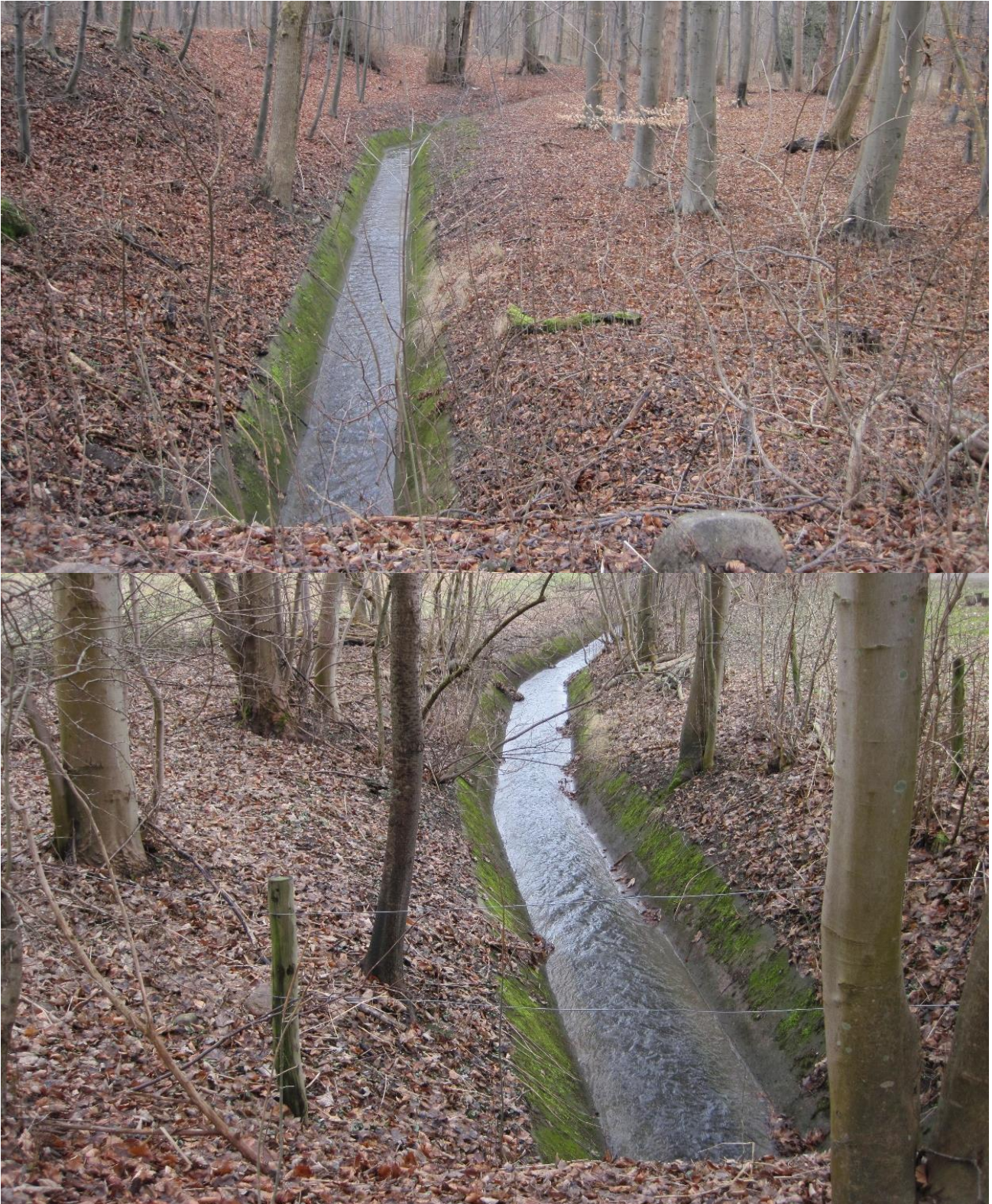
Figur 4.10: Den fliselagte strækning omkring st. 4.400 op- og nedstrøms set fra Allevej ved Torslunde. Det naturlige lavpunkt i terræn ligger på engen på venstre side nedstrøms på det nederste foto . NIRAS Marts 2021.
