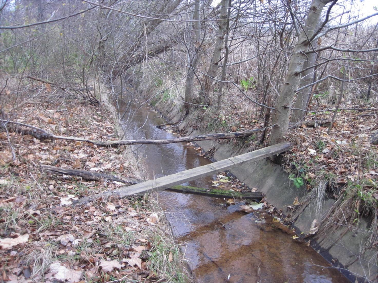
Figur 4.11: Den fliselagte strækning omkring st. 5.250 opstrøms. NIRAS december 2020.
