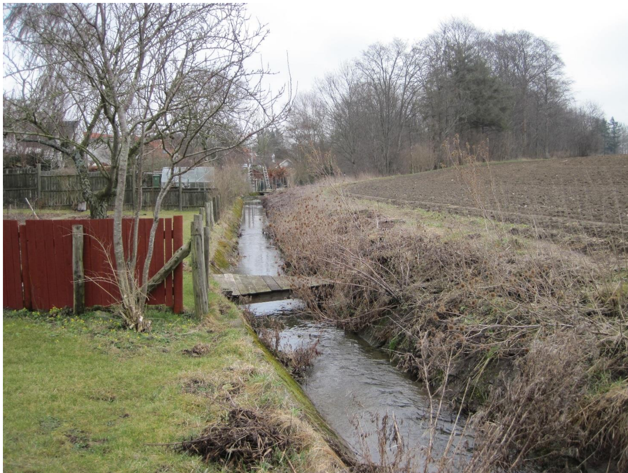
Figur 4.8: Den fliselagte strækning omkring st. 3.600 nedstrøms. NIRAS Marts 2021.
