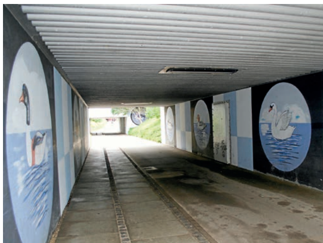
Eksisterende kunst: Jørgen Schwaner har 1976-1990 udsmykket 47 tunneller, som i dag er lokale kendetegn. Foto: medarbejder fra Zacho-Lind A/S
