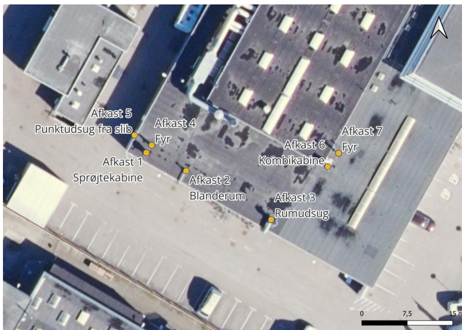
Figur 6: Ortofoto som viser de 7 afkast på taget fra blande-, tørre- og lakeringsrum samt fyringsanlæg på Industriskellet 3. Samme nummerering af afkastene er brugt i OML-beregningen.
