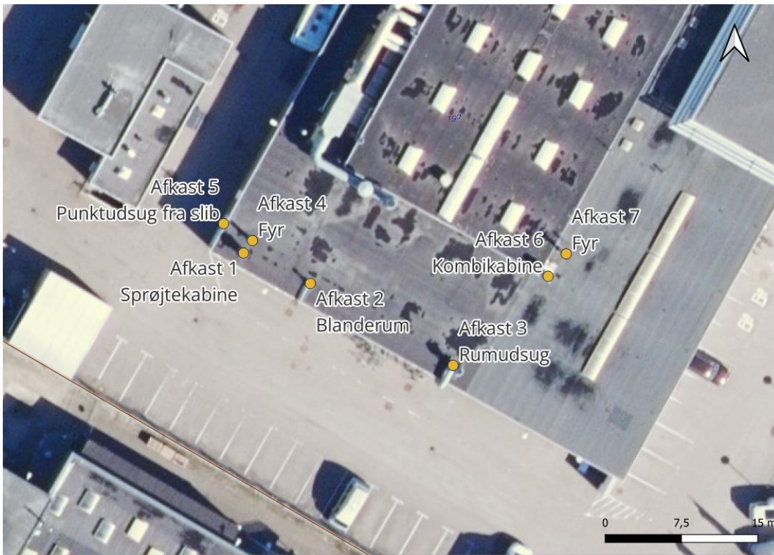
Figur 3 Ortofoto som viser de 7 afkast på taget fra blande-, tørre- og lakeringsrum samt fyringsanlæg på Industriskellet 3. Samme nummerering af afkastene er brugt i OML-beregningen.
