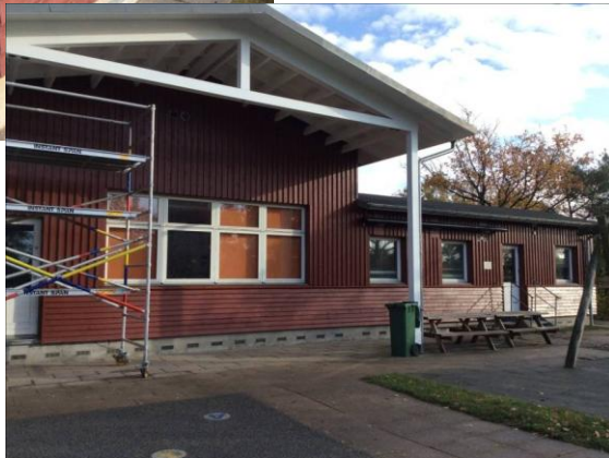
Foto af Krudthuset - efter
