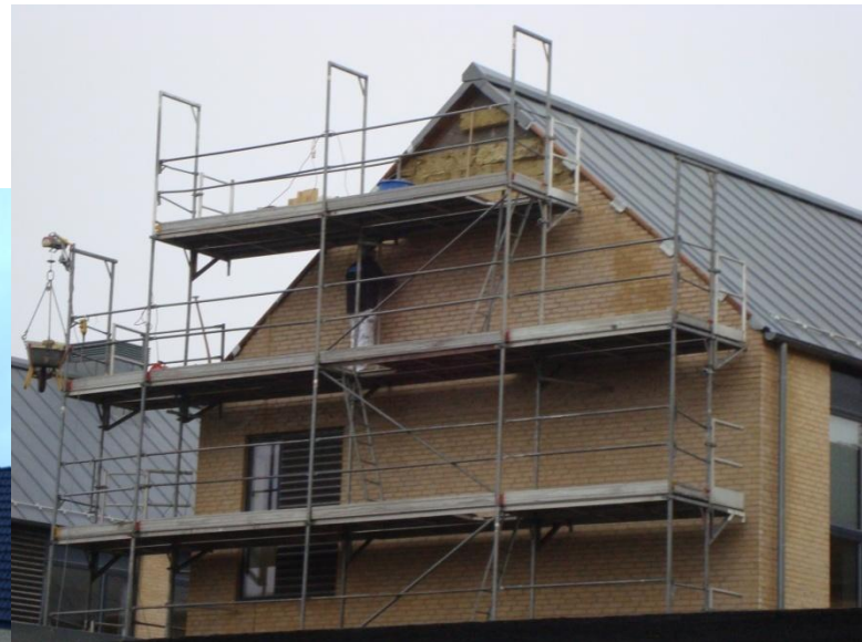
Foto af at arbejdet udføres
