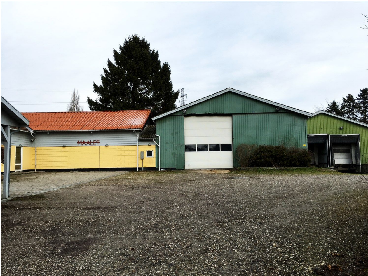
Erhvervsbygninger på Ishøj Bygade 11.
