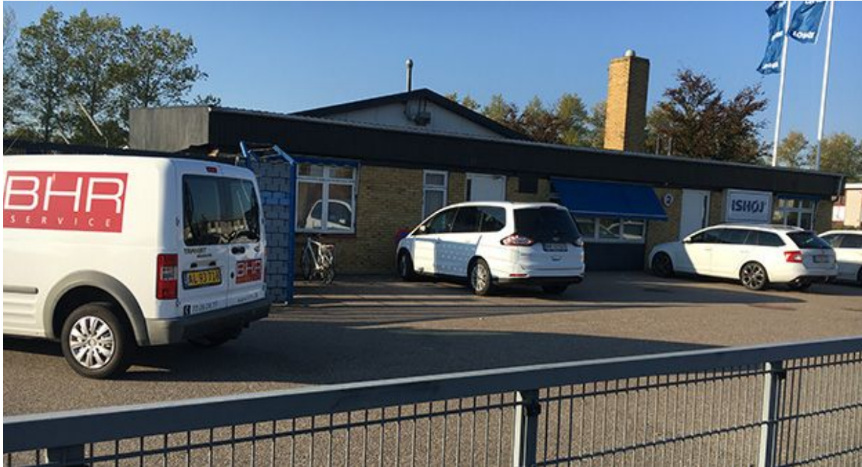
Virksomheden Ishøj Hegn der i dag ligger placeret på lokalplanområdet.
