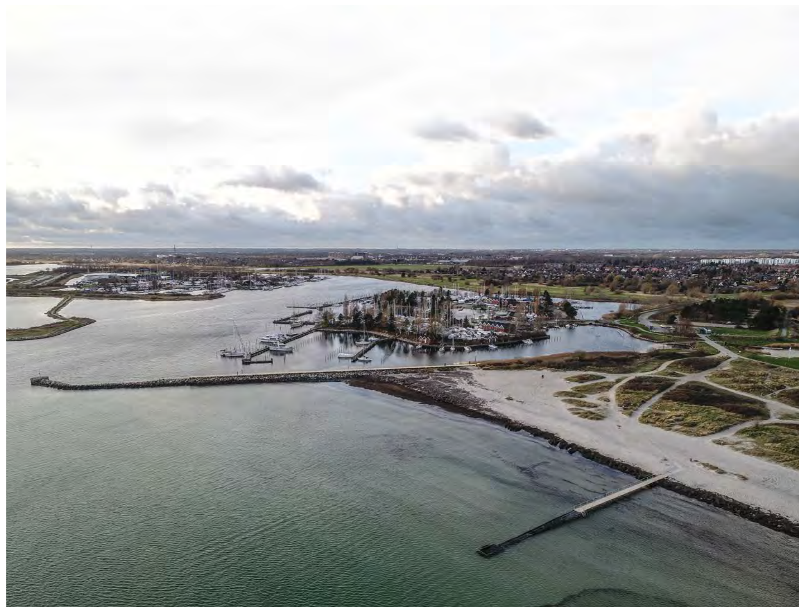
Fokusområdet ved Vallensbæk Strand, hvor molearmen netop har fået anlagt et trædæk, der skaber adgang til den fremtidige badeanstalt.
