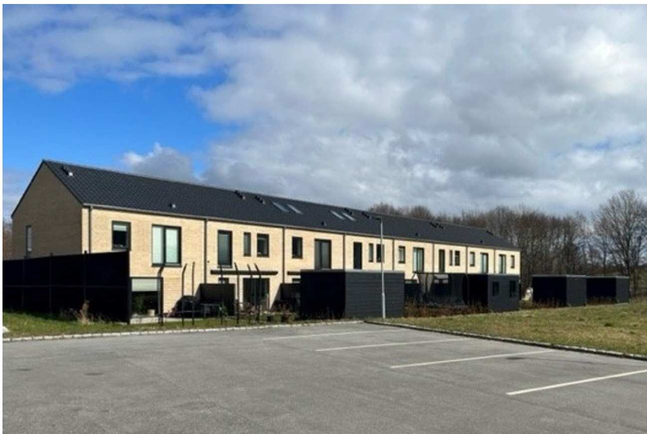
Rækkehusenes sydvendte haver med terrasser.
